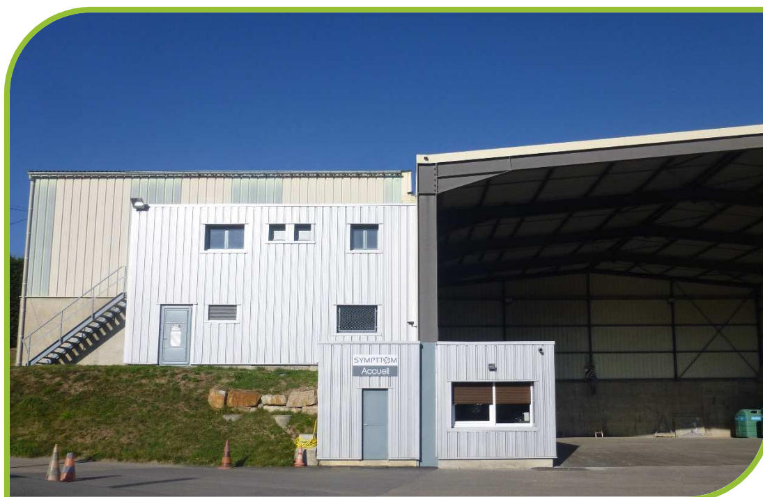
Nouveau local d'accueil de l'ISDND
