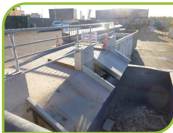
Nouveau quai gravats – Monistrol sur Loire
