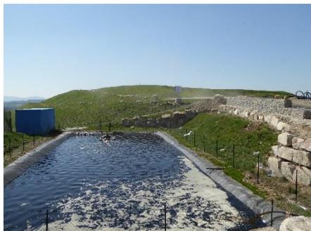
Un réseau de drainage permet de recueillir les lixiviats. Une partie de ces lixiviats est réinjectée dans les casiers afin de favoriser la méthanisation. L'autre partie est stockée dans une lagune puis traitée à la station d'épuration (STEP) de MONISTROL sur LOIRE.
