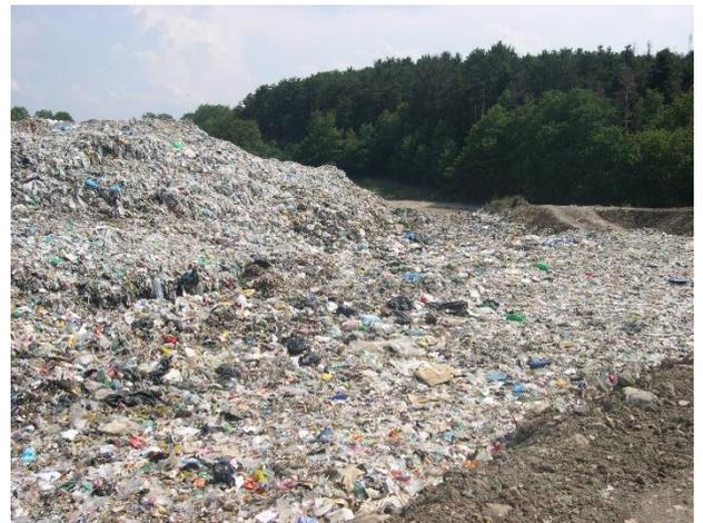
Le massif de déchets a été constitué par surélévation à partir du terrain naturel. Les talus de déchets présentent des pentes proches de 3H/2V pour des hauteurs de 8 à 9 m au maximum.
