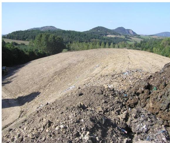
Pour limiter les infiltrations d'eau météorique dans le massif de déchets et réduire à terme la production de lixiviats, une couverture est mise en place sur l'ensemble du dépôt.
