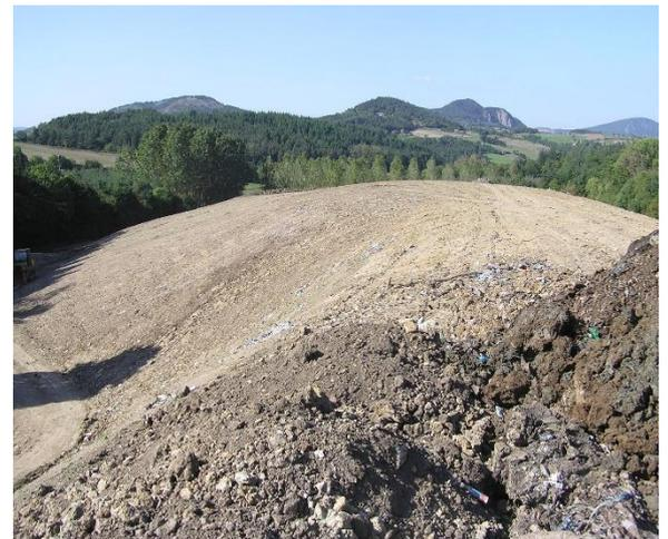
Pour limiter les infiltrations d'eau météorique dans le massif de déchets et réduire à terme la production de lixiviats, une couverture est mise en place sur l'ensemble du dépôt.
