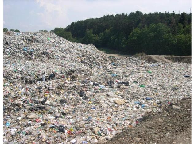
Le massif de déchet a été constitué par surélévation à partir du terrain naturel. Les talus de déchets présentent des pentes proches de 3H/2V pour des hauteurs de 8 à 9 m au maximum.
